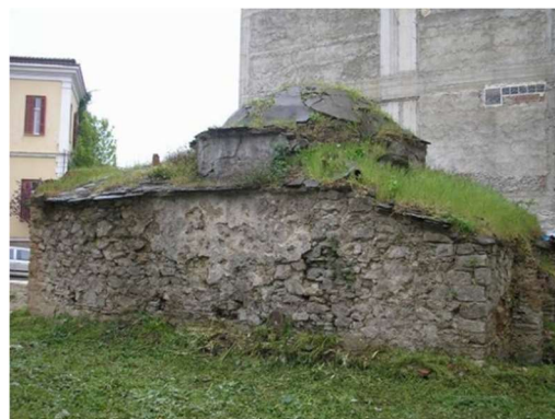
Άποψη του λουτρού από τα βορειοδυτικά 2
