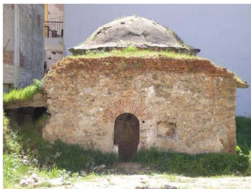
Άποψη του λουτρού από τα βορειοανατολικά 1
